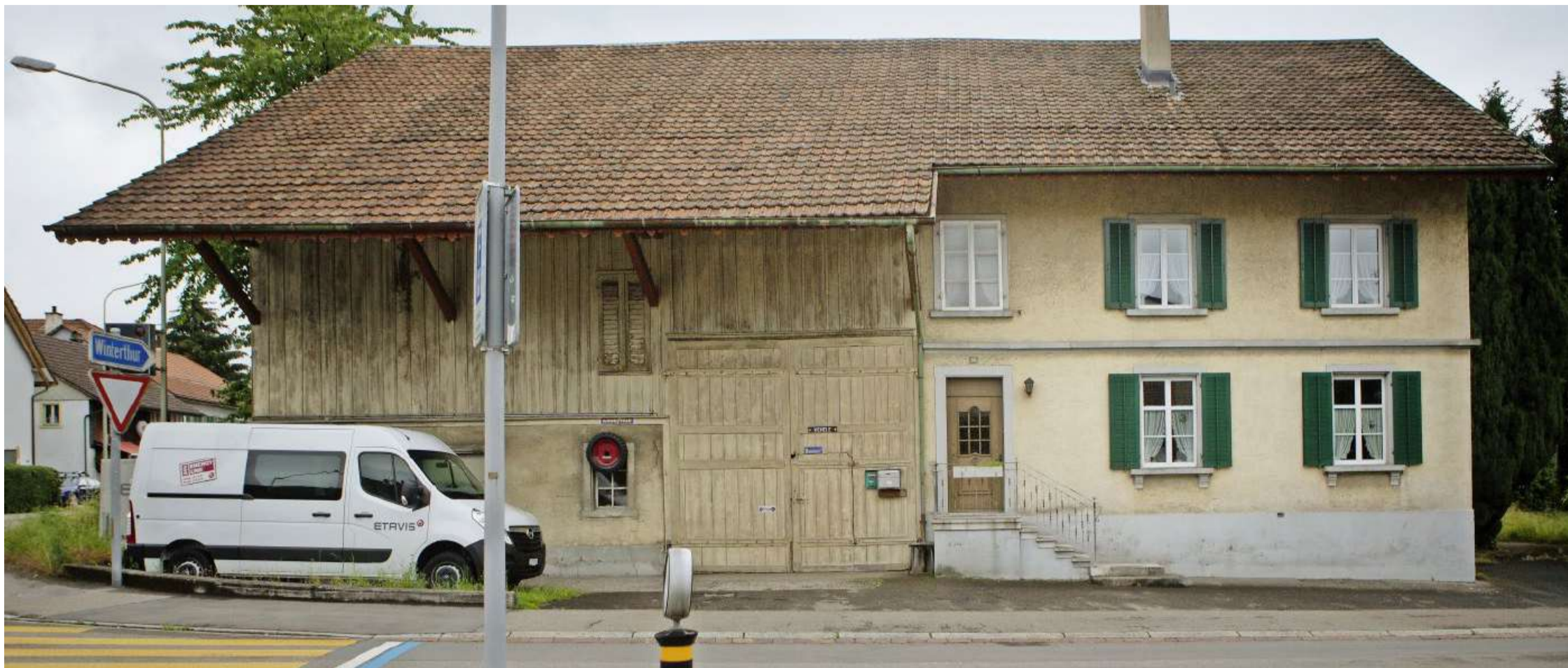
Dieses alte Bauernhaus sei ein wichtiger architekturhistorischer Zeuge für Kloten, befanden die Experten. Darauf stellte es der Stadtrat unter Schutz. Fotos: Sabina Bobst
