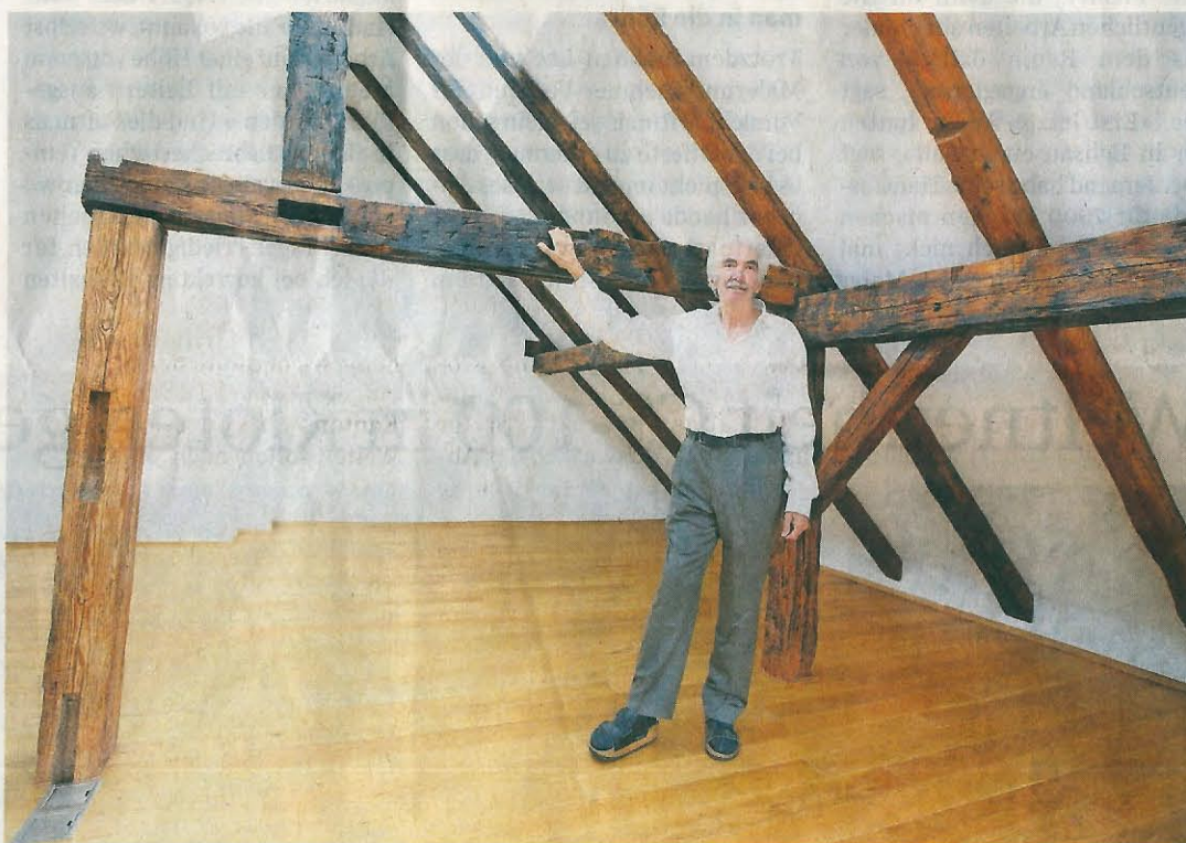
Frank Beat Keller leitete die Renovation des Bauernhauses. Er legte viel Wert darauf, dass die ursprüngliche Bauweise des Gebäudes erkennbar bleibt.
