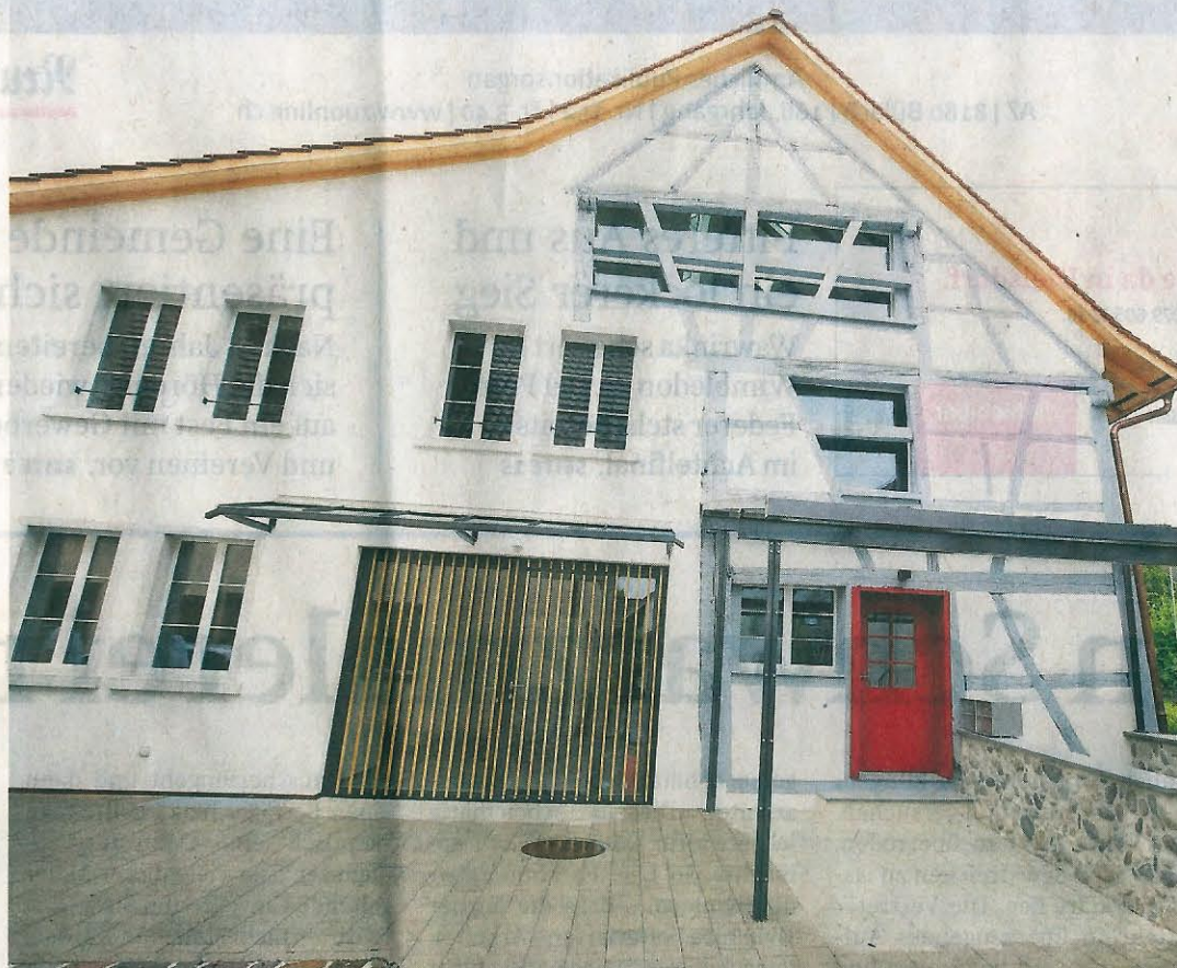
Das Bauernhaus aus dem Jahr 1651 an der Dorfstrasse 24 war völlig zerfallen. Nach rund einem Jahr Bauzeit erstrahlt es in neuem Glanz.
